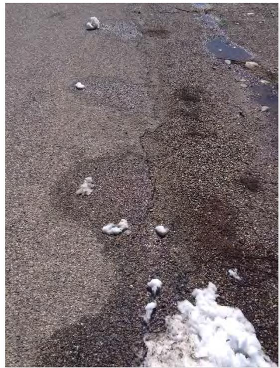
Figure 1. Edge Cracking in Ucon
