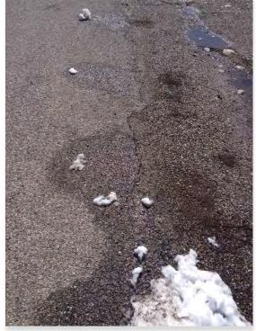
Figure 1. Edge Cracking in Ucon
